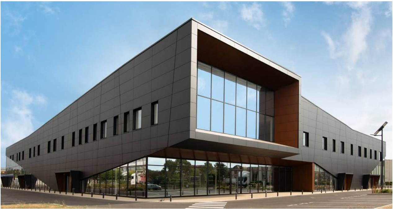
Bonneuil Sur Marne | office complex | France | STB-425
